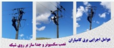
عوامل اجرایی برق کامیاران نصب سکسیونر و جدا ساز بر روی شبکه
